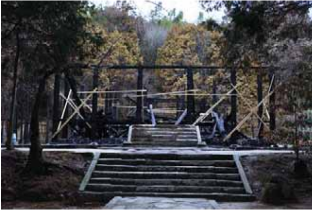
図7 被災した本堂の正面
