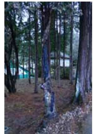
図14 被災した樹木
