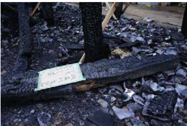
図11 焼損部材取り扱いに関する注意札
